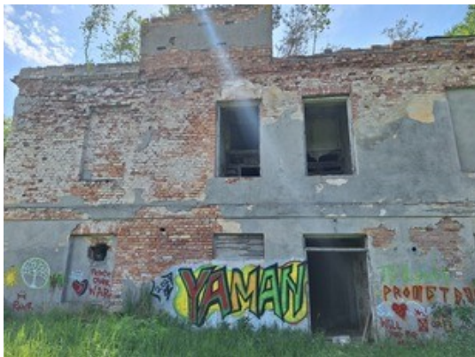
1.2.5-1 Administratīvā ēka ar kadastra apzīmējumu 0900 023 0012 016
