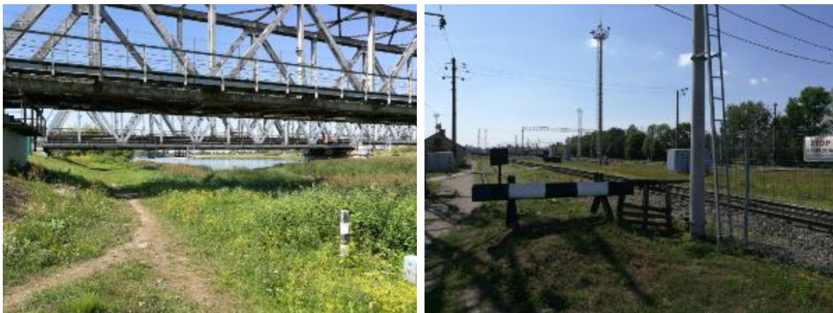
59.attēls. Gājēju taciņas zem dzelzceļa tilta un vienā līmenī ar dzelzceļu Lielupes kreisajā krastā. Autors: R.Krūmiņš.
